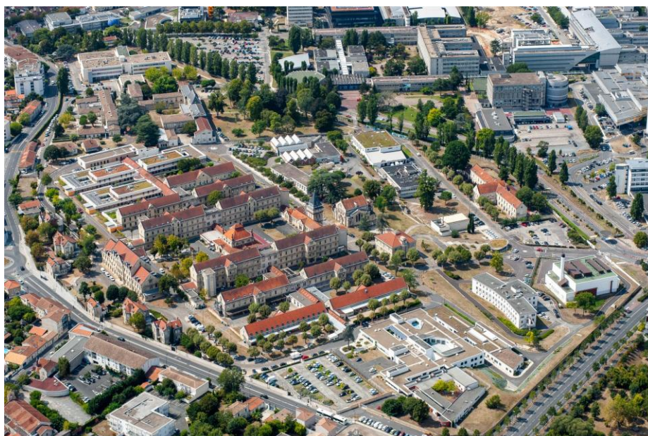
Vue aérienne du Centre hospitalier Charles Perrens
